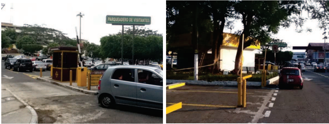
FOTOS #9 Y #10 ESTACIONAMIENTOS DE VISITANTES, NUEVAS INSTALACIONES DEL BANCO DEL PICHINCHA DENTRO DEL AREA DE ESTACIONAMIENTOS.
