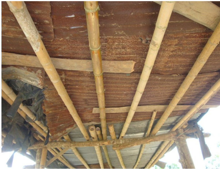
Foto No.7: Cubierta del puente de madera actual.
