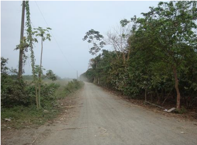
Foto No.1: Entrada al recinto Rio Chico 4 (7.5 Km)
