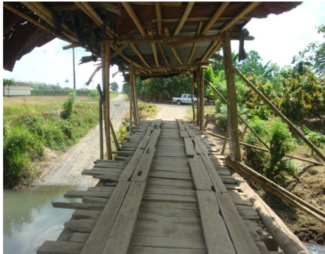
Foto 3.1: Perfil transversal del puente de madera actual.
