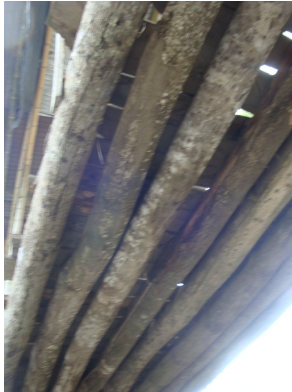
Foto No.8: Base del puente de madera actual
