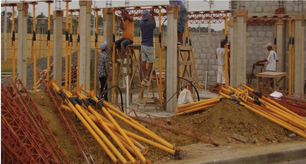
FOTO 19 Columnas desencofradas y preparación de la losa
