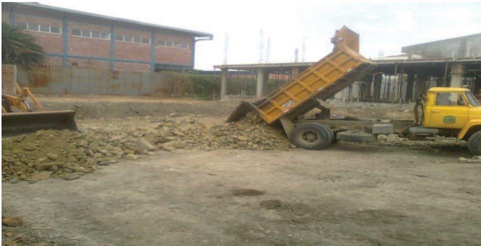
FOTO 4 RELLENO DEL TERRENO
