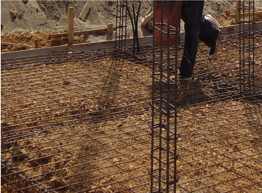
FOTO 14 HIERRO EN LA CIMENTACION
