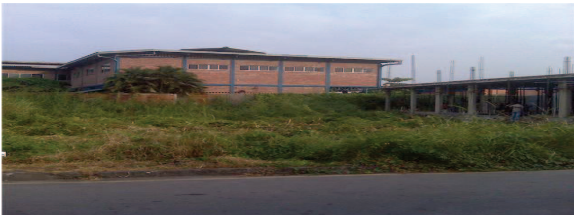
FOTO 1 TERRENO SIN LIMPIAR
