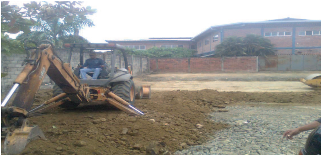
FOTO 8 Relleno y compactacion segunda capa
