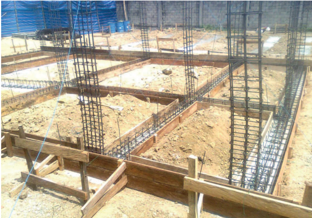
FOTO 16 COLOCACION DEL HORMIGON
