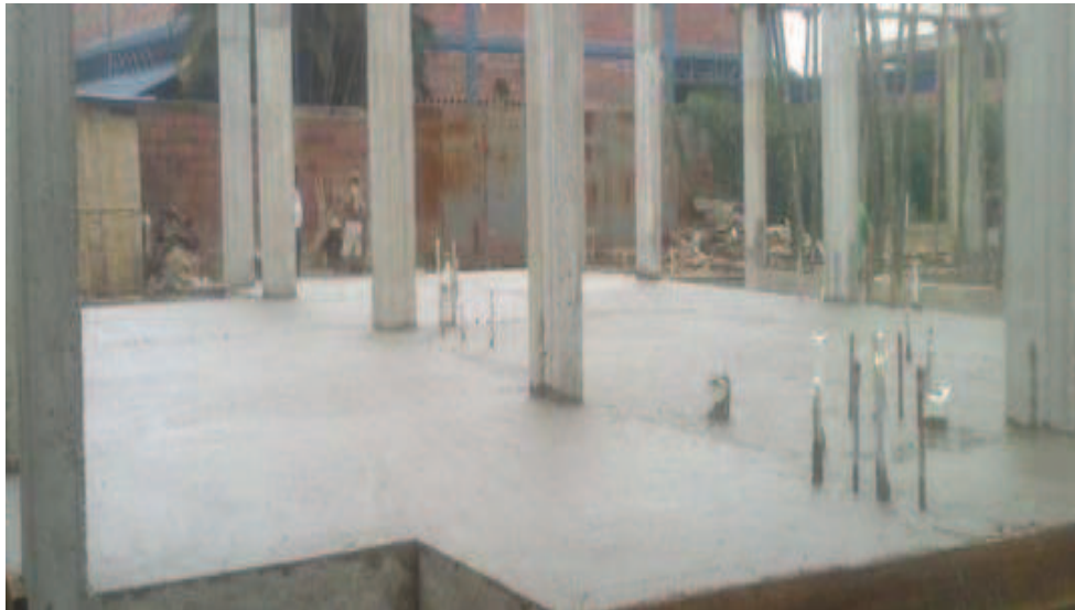
FOTO 25 Columnas y cimentación con las redes empotradas
