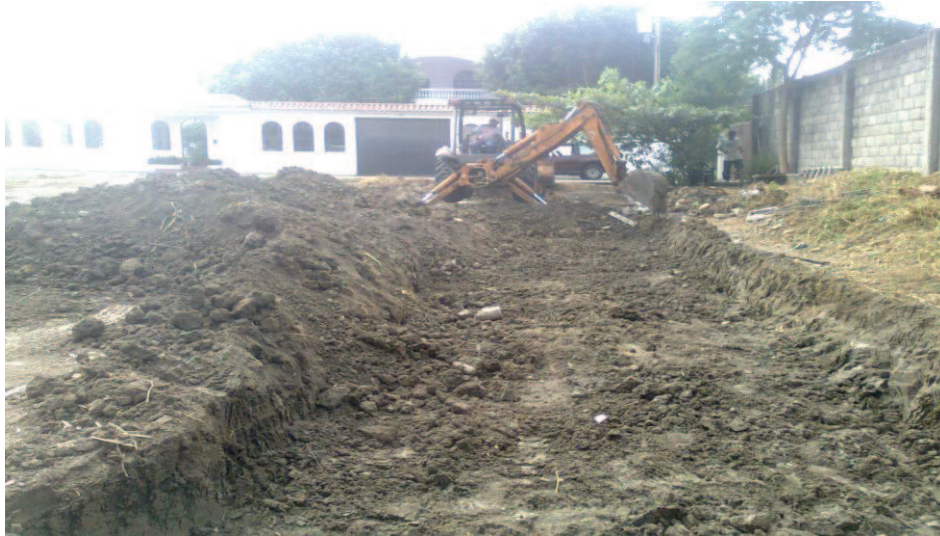
FOTO 3 EXCAVACION DE SUELO
