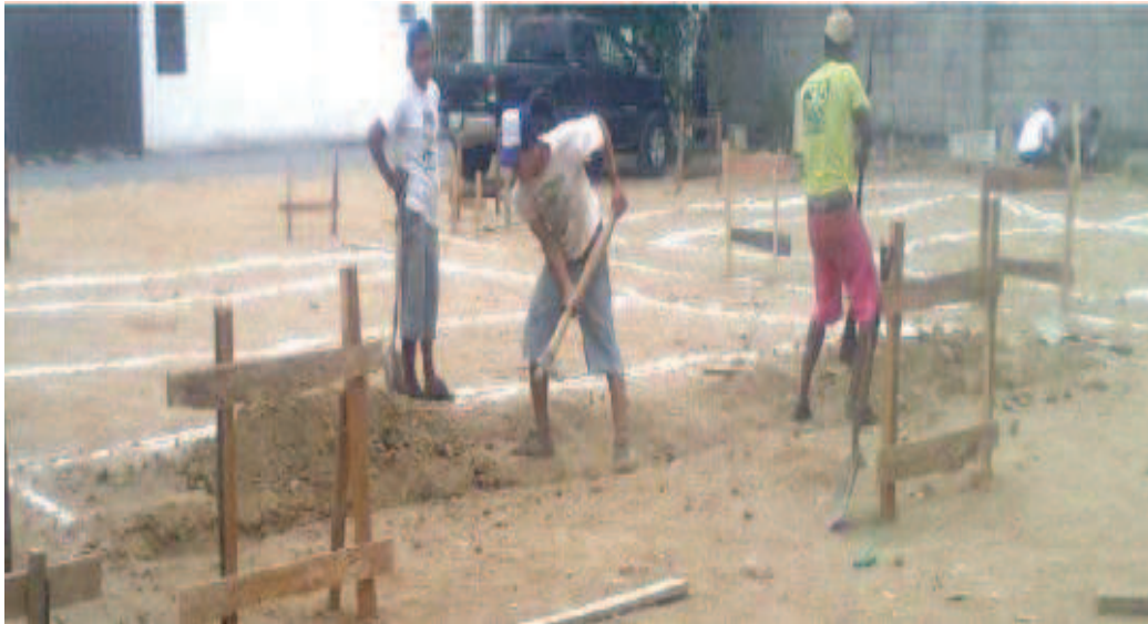
FOTO 12 EXCAVACION MANUAL
