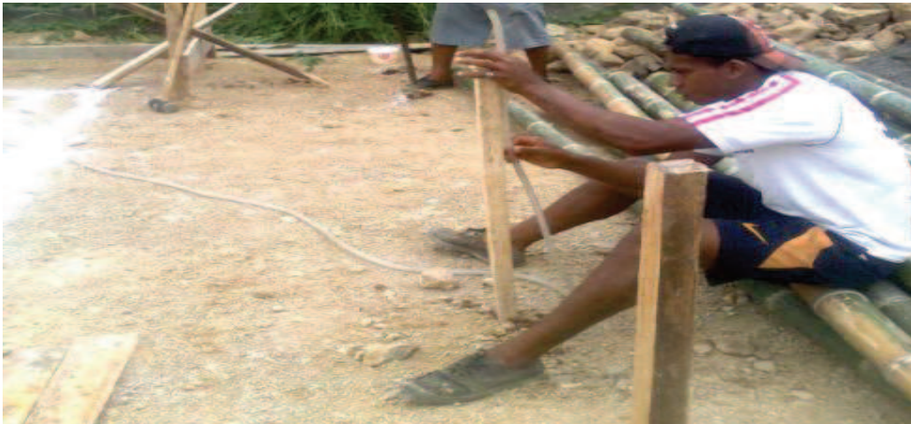
FOTO 11 NIVELACION EN OBRA
