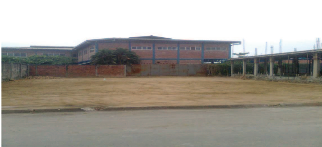
FOTO 9 Terreno limpio, relleno y compactado
