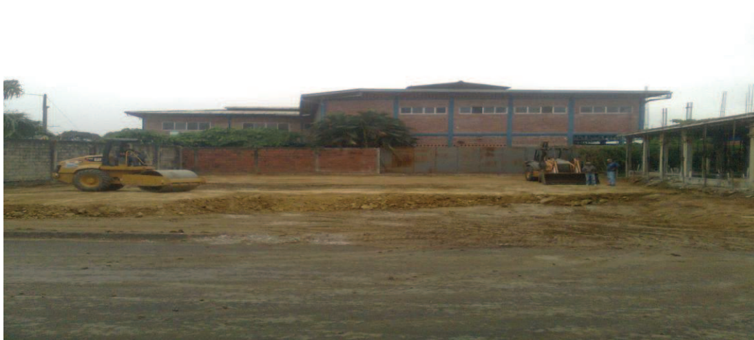
FOTO 8 Relleno y compactacion segunda capa
