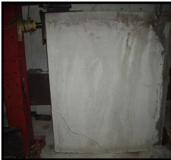
Foto 41: Falla a corte de la pared MP
