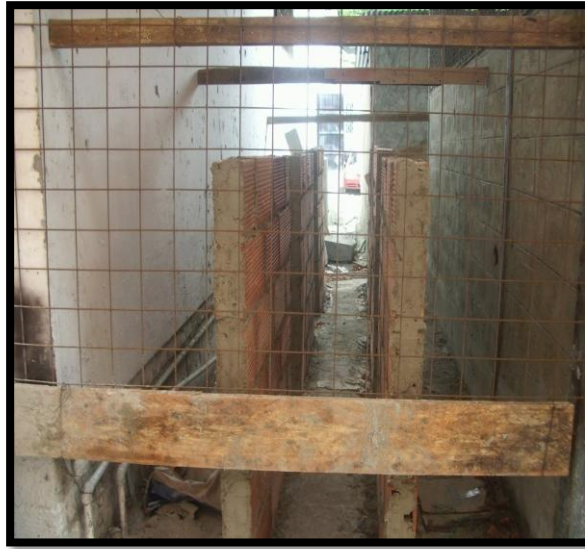
Foto 36: Protección de las paredes
