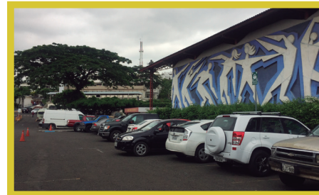
1. parqueadero frontal del coliseo
