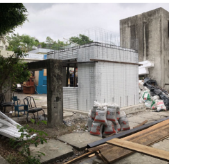
10. Pruebas realizadas por Ing. civil
