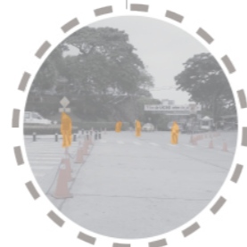
Ilustración 15: Delimitación de la vía por medio de conos. Tipán, A. (2018)
