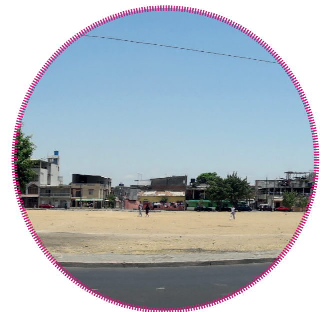
6. La imagen Urbana deteriorada, las fachadas de las manzanas se encuentran en mal estado, la propuesta busca ser un elemento que mejore la imagen del sector mediante el diseño de fachadas.
