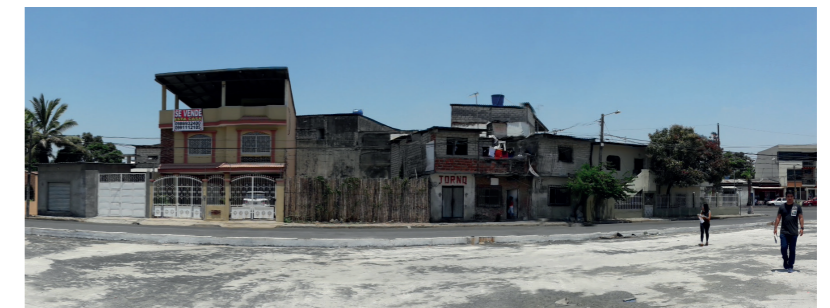
Perfil urbano deteriorado
