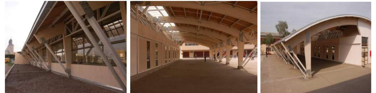
Las aulas se agrupan bajo una bóveda que se soporta con una estructura regular de madera. Se genera un pasillo como antesala a los salones. Se destaca los vanos como medio de ventilación e iluminación natural. El material predominante es la madera y el metal. Ambos materiales se fucionan estructuralmente en las paredes y elementos decorativos.
