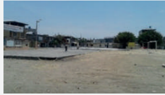
Figura 4. Superficies de hormigón existentes. Autor: Parra, 2018
