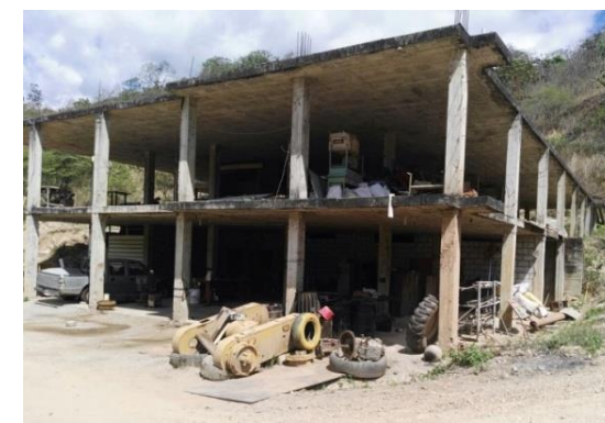
Figura 4: terreno y estructura asignados por el GAD para el proyecto Fuente: elaboración propia
