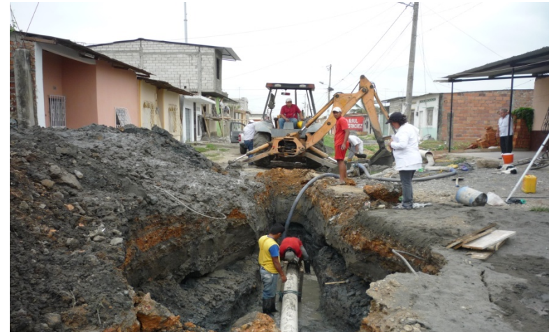
C.8 Instalación de Tubería de PVC
