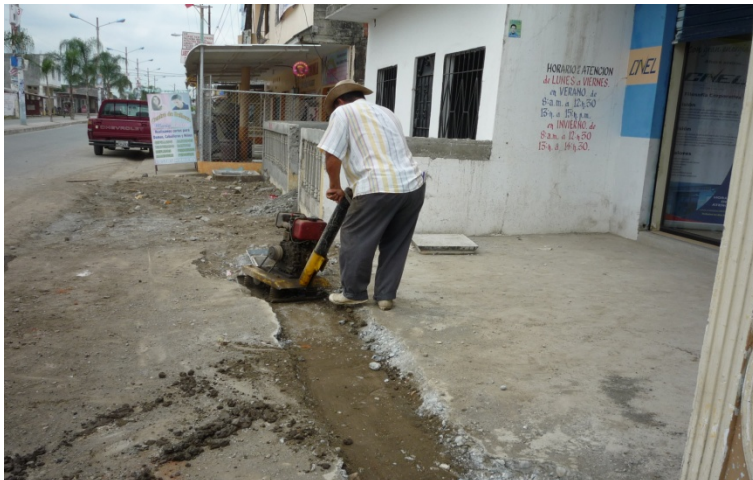
C.3 Compactación del material
