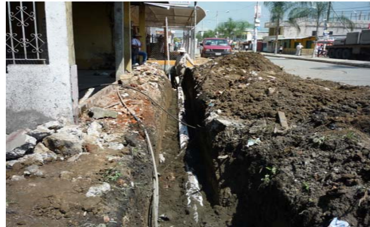
C.2 Colocación de Tubería PVC
