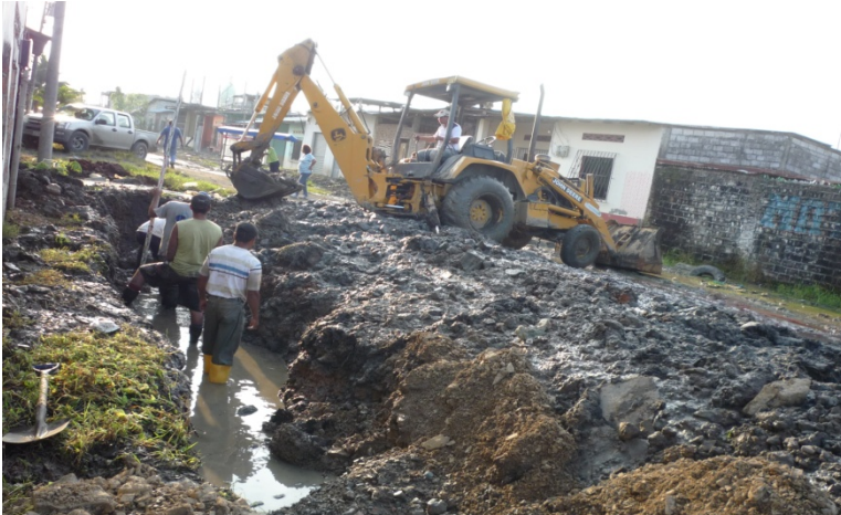
C.5 Excavación sin Clasificar
