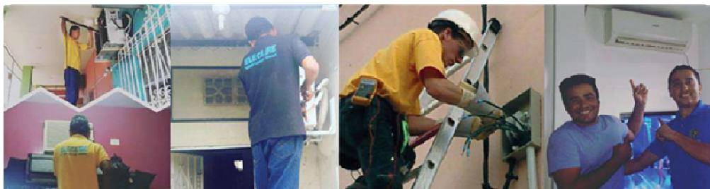
Figura 7 Personal de ELECLIRE dando servicio de mantenimiento y reparación
