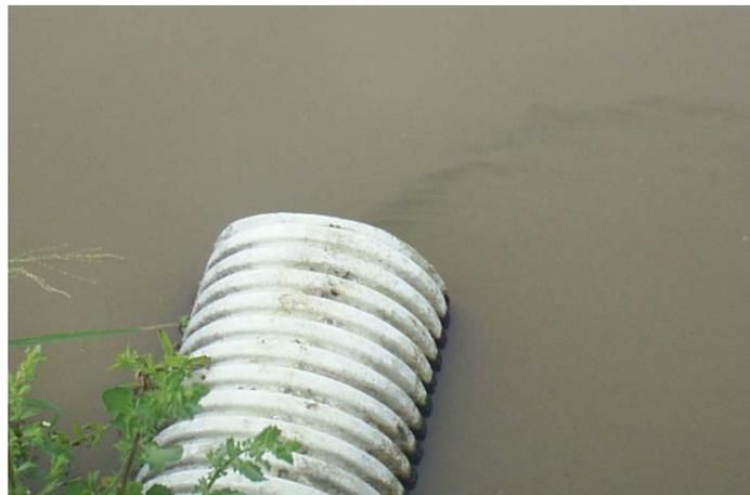
**Foto 4.10 Tubería de descarga a la laguna 2**
