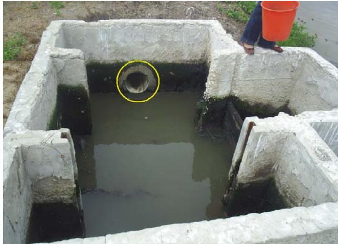
**Foto 4.9 Tubería de repartición de caudal a la laguna 2**
