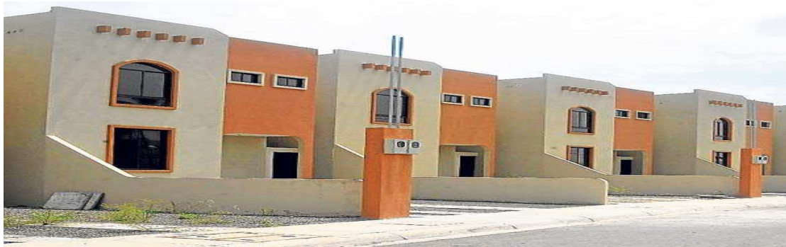
Ilustración 41 Construcción de la Ciudadela Panorama de Duran
