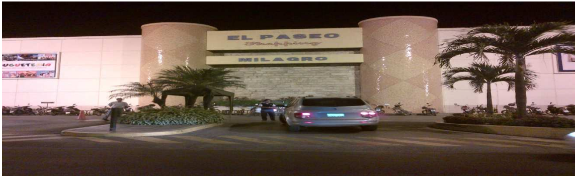
Ilustración 44 Remodelación del Shopping de Milagro
