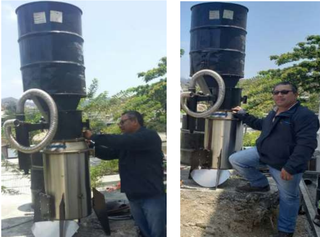
Figura 4. 7 Montaje de tolva con reactor
