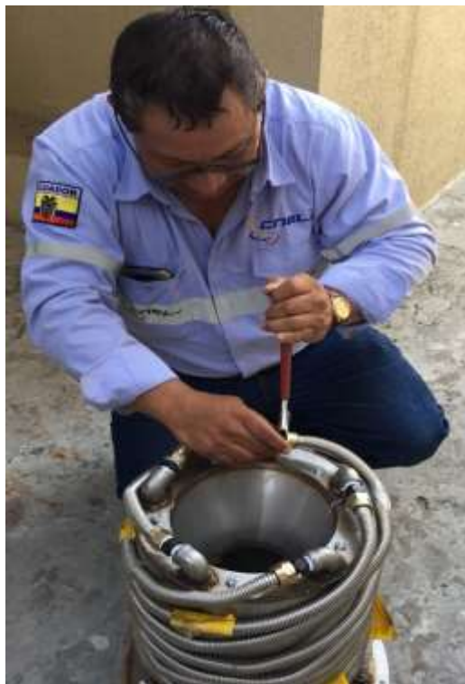
Figura 4. 6 Conexiones de las mangueras de quemadores
