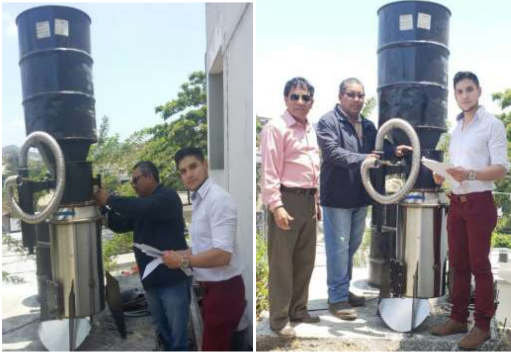
Figura 4. 8 Terminación del montaje con supervisión del ing. Martillo
