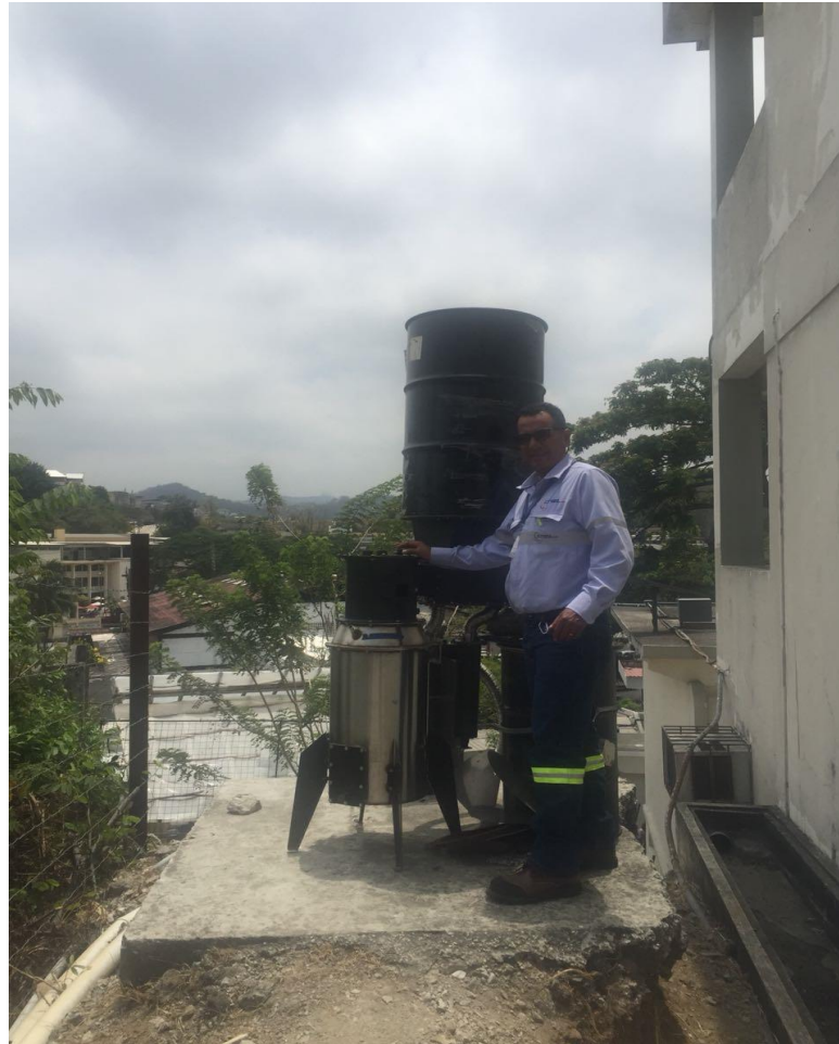
Figura 3. 19 Terminación del montaje
