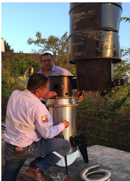
Figura 3. 18 Montaje de reactor con tolva
