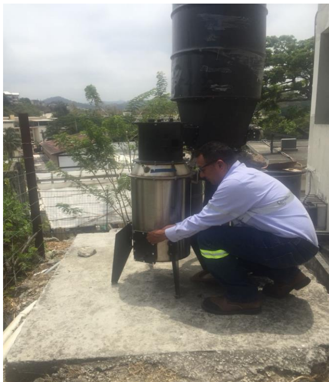
Figura 3. 17 Instalación de reactor
