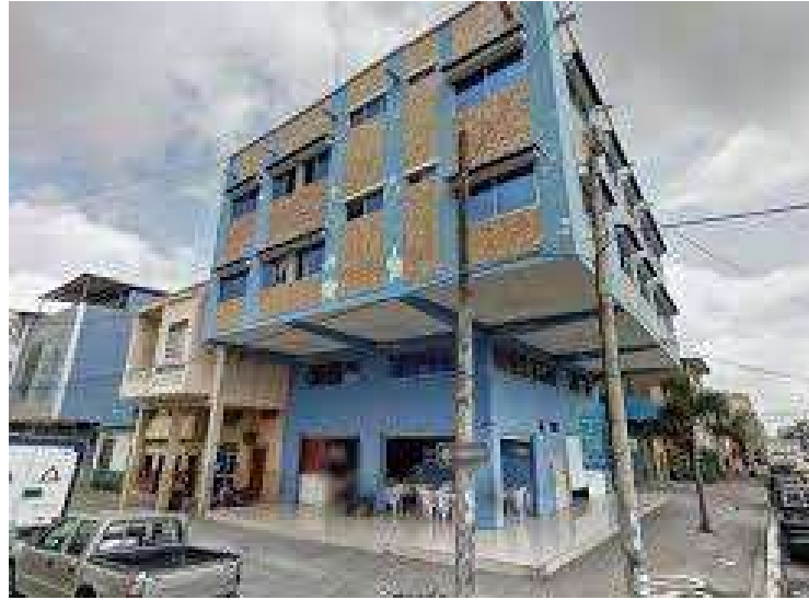
Ilustración 19. Edificio de la esquina Ayacucho y García Moreno en Guayaquil, antes del evento de 16 de abril de 2016.
