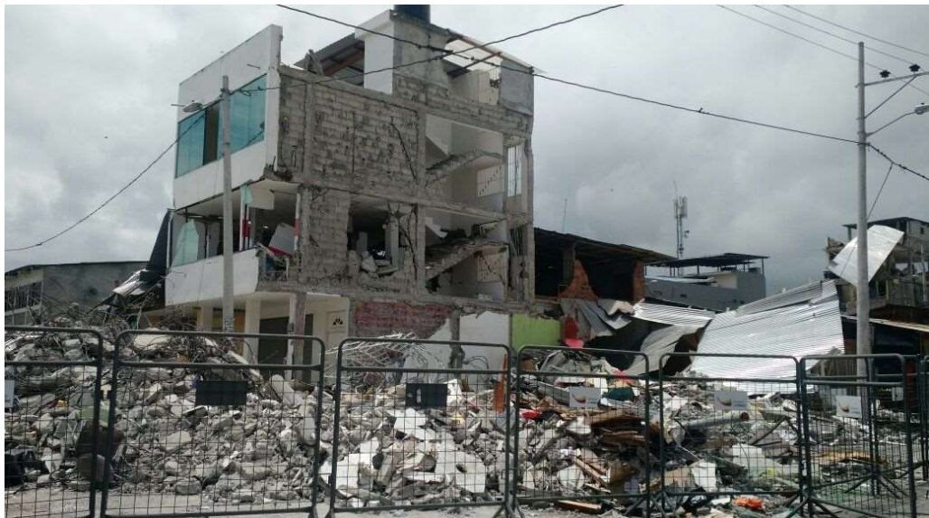
Ilustración 2. Destrucción de viviendas y hoteles tras el sismo en Pedernales del 2016
