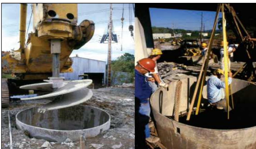
Ilustración 11. Perforación de subsuelo para la construcción de pilote barrenado mediante el método de camisa
