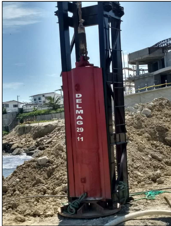
Ilustración 6. Martillo de caída libre para prueba PDA de proyecto
