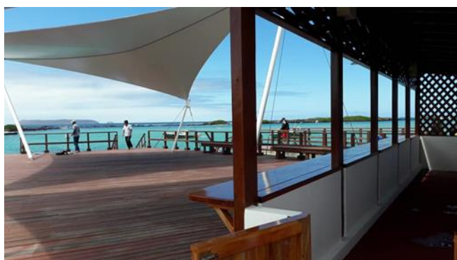
Figura 13. Muelle de ingreso y salida de pasajeros en Puerto Villamil.
