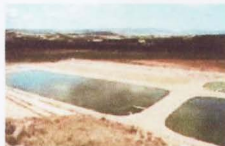
(Foto 29). LAGUANAS DE TRATAMIENTO
