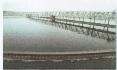
(Foto 24). LAGUNA DE SEDIMENTACION
