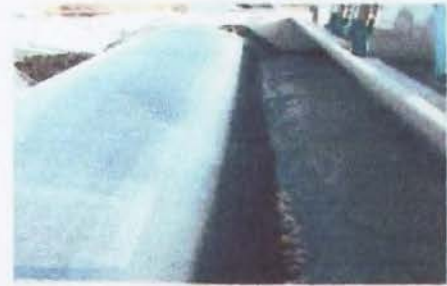
(Foto 31). PROCESO DE MICROFILTRACION
