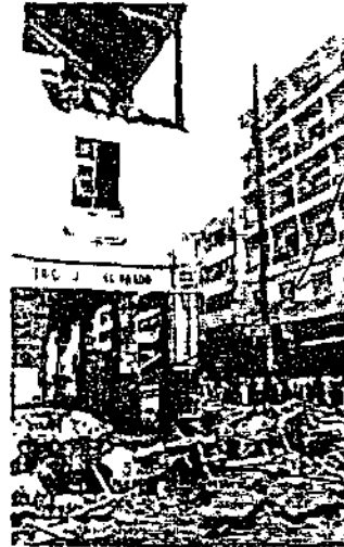
Foto No.4 Daños a casas mixtas
