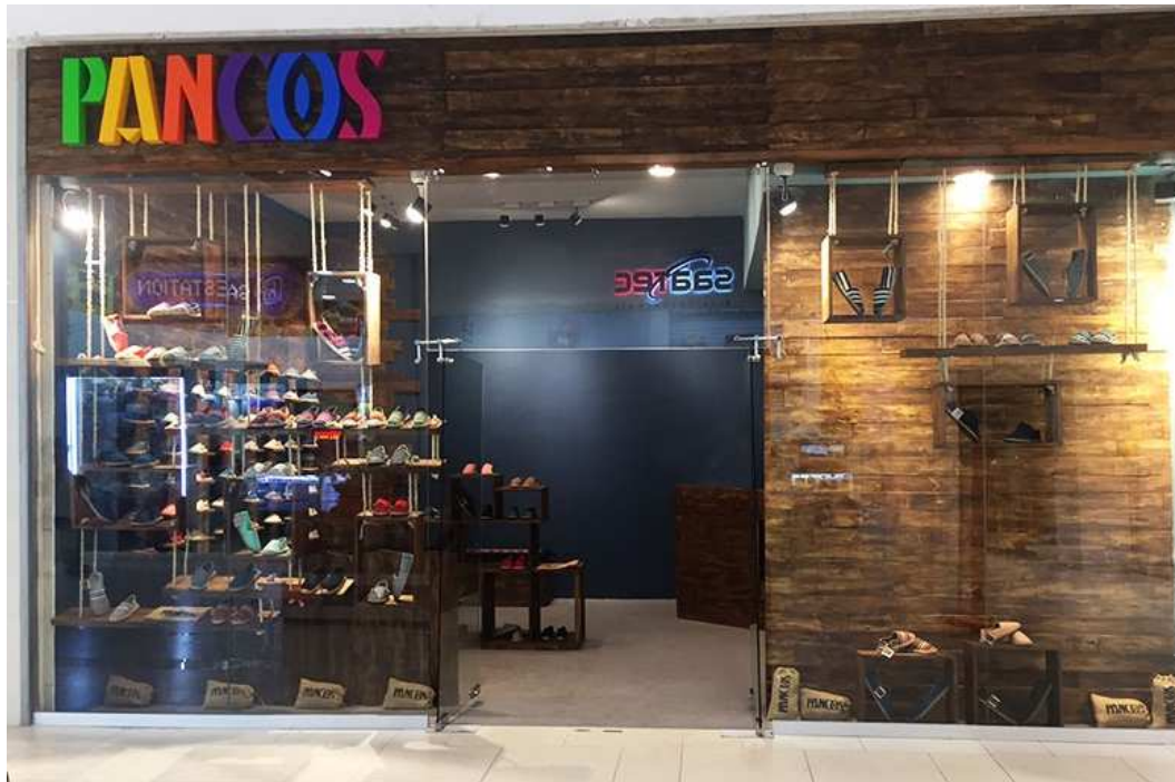
Figura 23. Fachada del Local Pancos, ubicado en el Rio Centro el Dorado, 2018.
