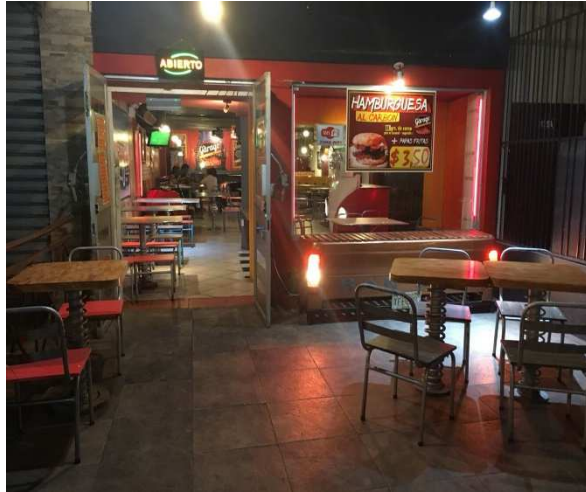
Figura 82. Fachada actual del restaurante
