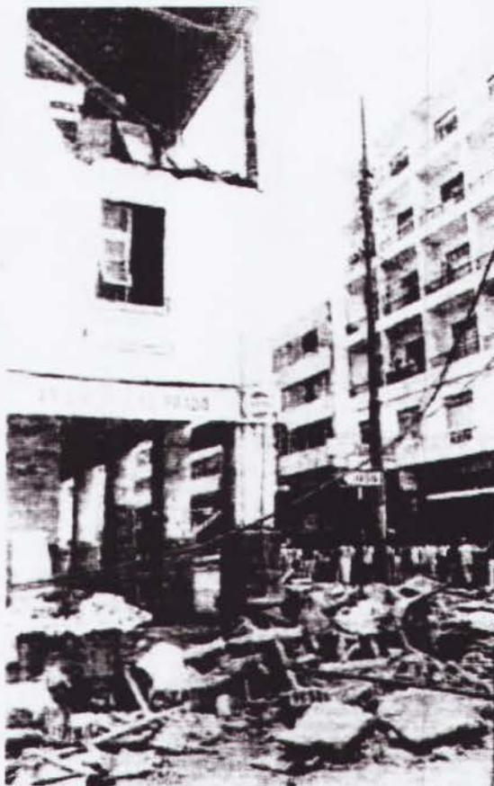
Foto No. 4 Colapso de paredes de mampostería en edificaciones.
