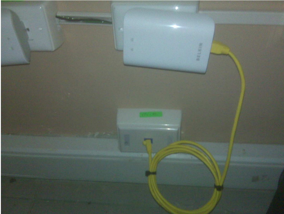
Figura A3.1: Adaptador PLC Uplink. Se aprecia la conexión al cableado hacia el bastidor.
