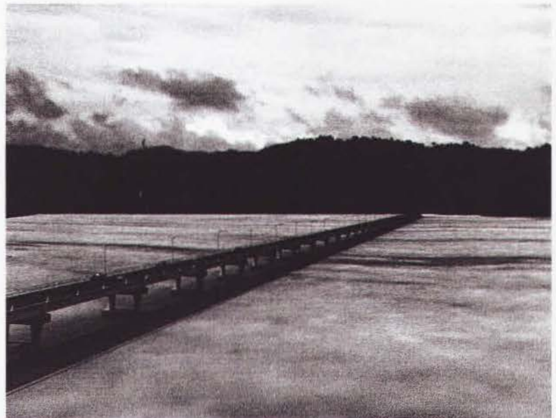
Figura 1. Digitalización del Puente Terminado
