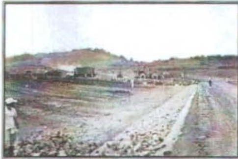
FILTRO PARA LIXIVIADOS
