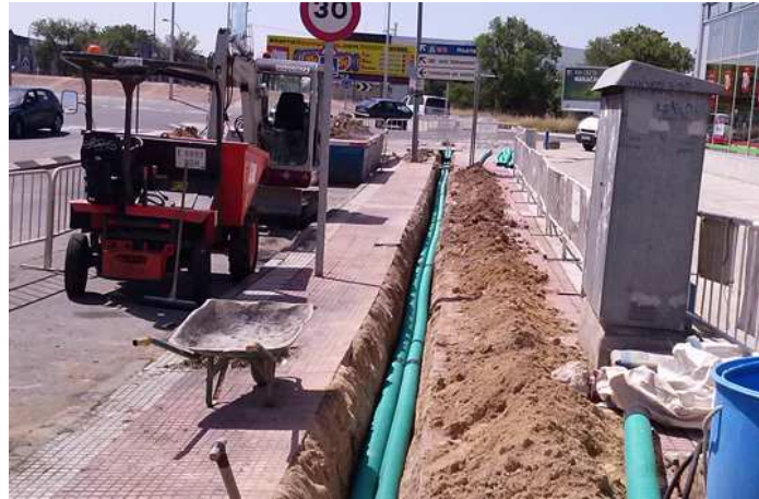
Figura 2. 2: Trabajo de excavación para proyecto FTTH. Fuente: (Icadsa, 2017)
