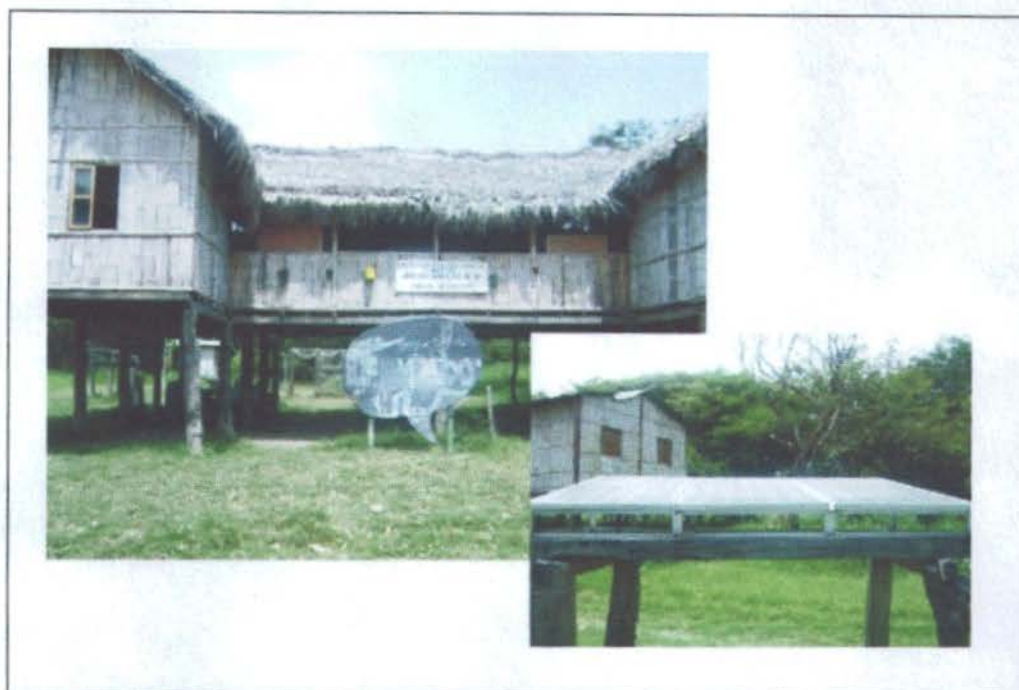
Paneles Solares en la Escuela "Jaime Roldós A."
