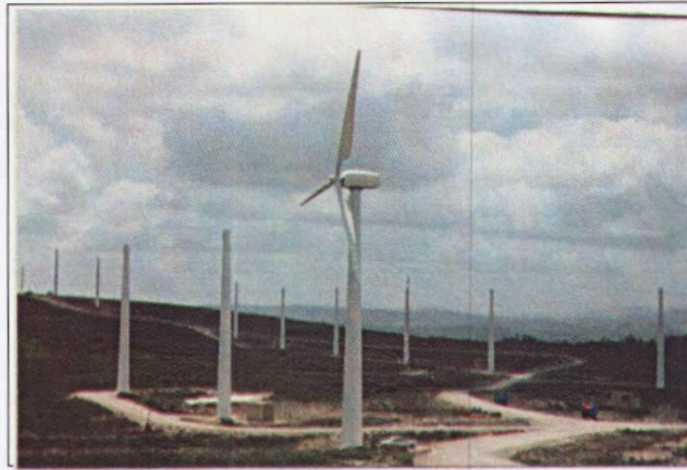
Figura 2.30: Accesos y montaje de un parque eólico. (Tuleda, 06).
