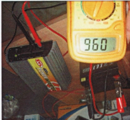
Figura 4.21: Prueba de batería e inversor. (Fotografía tomada durante el desarrollo de pruebas eléctricas).
