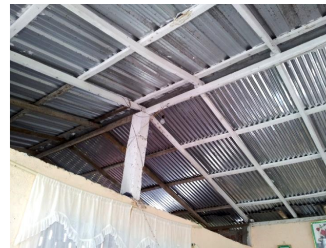
Imagen 74: Imagen de los dos tipos de cubierta y su estructura de madera.
