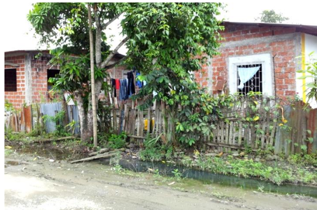
Imagen 44: Canal natural en la calle conduce las aguas lluvias a zonas más bajas.
