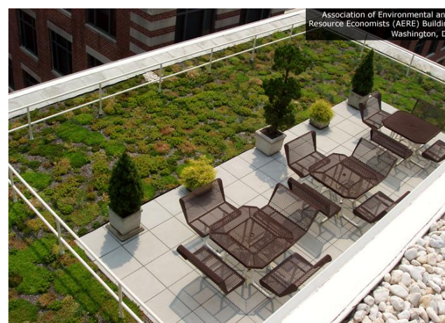
Imagen 181: Cubierta verde del Association of environmental and resource economists (AERE) building. Washington DC. (Google imágenes, 2012)
