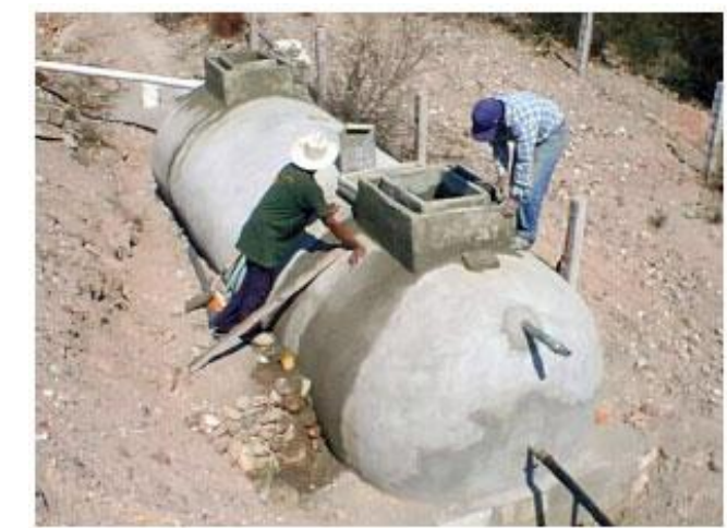
Imagen 209: Sistema biodigestor anaerobio de hormigón. (Google imágenes, 2012)
