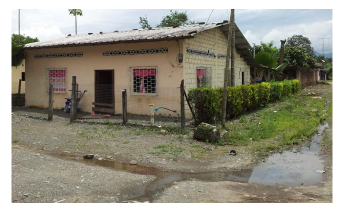
Imagen 69: Canal natural en la calle conduce las aguas lluvias a zonas más bajas.
