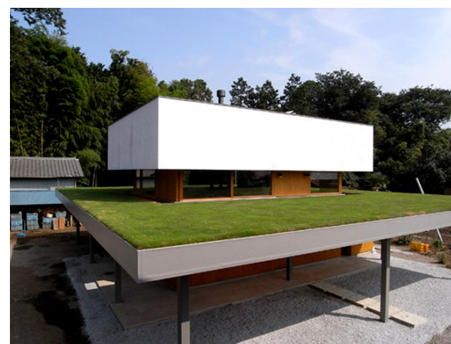
Imagen 134: Cubiertas de hormigón armado alivianadas y uso de césped como acabado. (Google imágenes, 2012)
