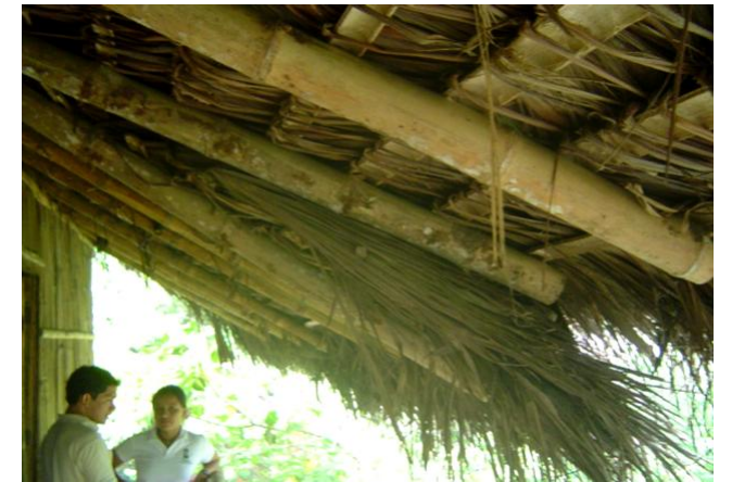
Imagen 110: Volado de la cubierta y los elementos que la componen. (Armijos. Matamoros & Santana, 2006)
