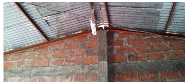
Imagen 50: Fotos de la vivienda y sus elementos constructivos con cero presencia de fisuras por asentamientos o sismos anteriores.
