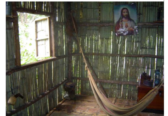
Imagen 111: interior de la vivienda mostrando su estructura de madera y paredes de caña picada. (Armijos. Matamoros & Santana, 2006)
