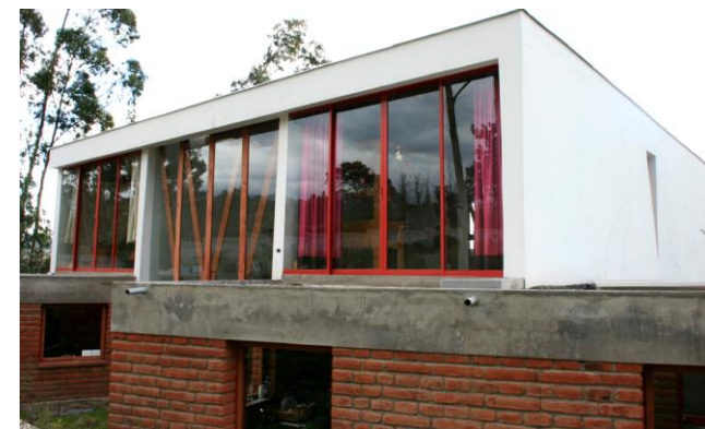
Imagen 129: Imágenes de una construcción con bahareque. (Cevallos, 2011)
