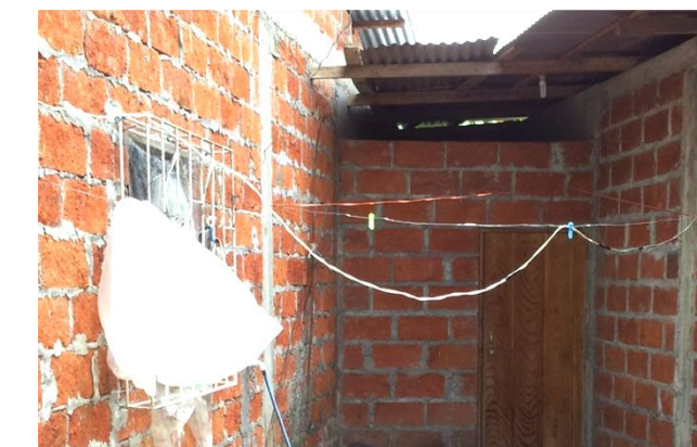
Imagen 34: Fotografía de la vivienda con otros elementos como rejas de ventana, puerta y cuartones y tiras de madera de la cubierta del baño.
