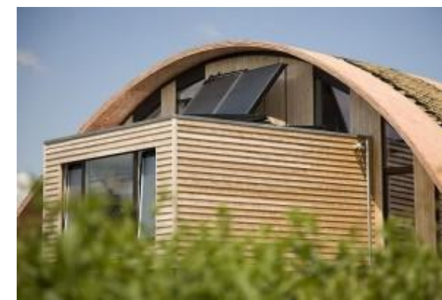
Imagen 152: Paneles solares híbridos como alternativa de consumo energético en una vivienda. (Rodríguez J. , Subinet.es, 2011)
