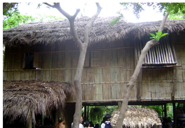
Imagen 113: Aleros de la vivienda con su piso elevado y el material de cubierta de cade. (Armijos. Matamoros & Santana, 2006)
