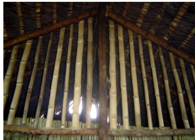
Imagen 114: Paredes y cubierta dispuestas para obtener una ventilación e iluminación apropiada. (Armijos. Matamoros & Santana, 2006)
