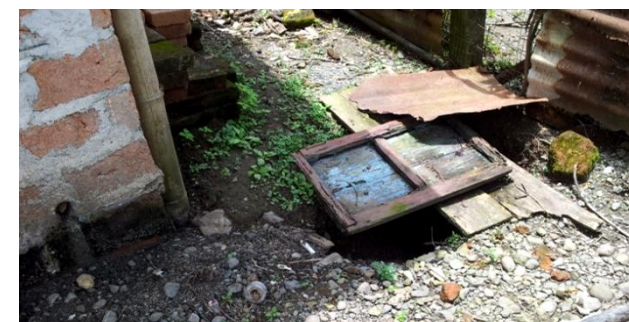
Imagen 66: Tapa del pozo séptico en el patio de la vivienda analizada.
