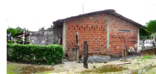
Imagen 61: Vista de la fachada lateral (Este) de la vivienda con los materiales que la componen y sus acabados.
