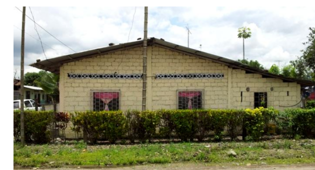
Imagen 60: Vista de la fachada lateral (Oeste) de la vivienda con los materiales que la componen y sus acabados.
