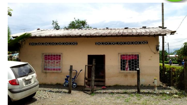
Imagen 59: Vista de la fachada principal (Norte) de la vivienda con los materiales que la componen y sus acabados.
