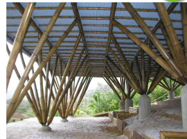
Imagen 201: Alternativas del uso de la caña guadúa como estructura, con cimientos de hormigón armado. Obra del Arq. Simón Vélez.
