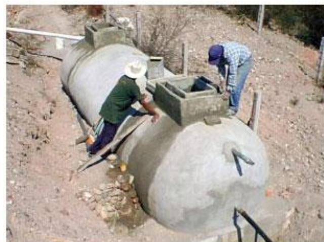
Imagen 179: Sistema biodigestor anaerobio de hormigón. (Google imágenes, 2012)
