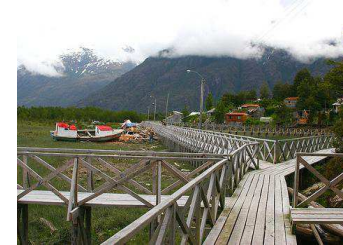
Foto No. 4: Conexión de pasarela Fotografía: Douglas Fernández(2007).
