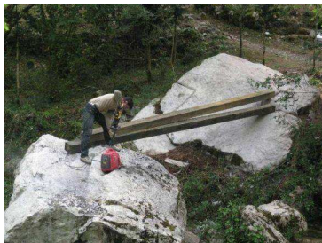
Foto No. 16: Perforación de la Roca Fotografía: SolucioNAT
