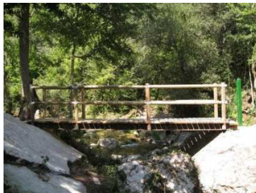
Foto No. 17: Pasarela Apoyada sobre Roca Fotografía: SolucioNAT
