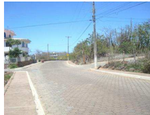
Foto No. 31 Red de Media Tensión Fotografía: Tesista MCLG (2011).
