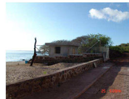
Estado original de la topografía de Playa Mann Fotografía: Arq. Fredy Olmedo (2004)
