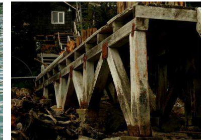
Foto No. 7: Apoyo estructural Fotografía: Douglas Fernández(2007).
