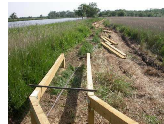
Foto No. 14: Proceso Constructivo Fotografía: SolucioNAT
