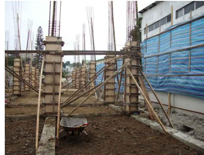
6. La losa debe ser liviana y de fácil construcción, es por esto que al igual que las columnas se plantea la construcción de una losa Maciza de 12cm de espesor mediante el sistema tradicional. De esta manera al unirse la losa a las vigas se garantiza su unión monolítica al resto de la estructura capaz de resistir las cargas tanto verticales como horizontales.
