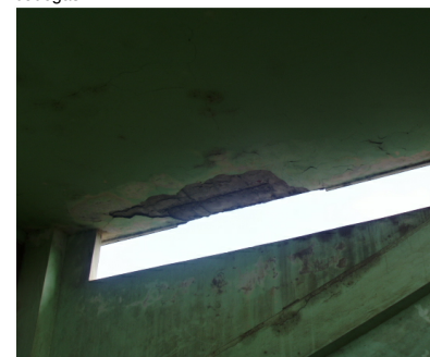
I11. Grietas en los elementos estructurales debido a las filtraciones de agua.
