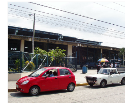
I01. Ingreso principal.
