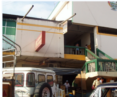
I06. Accesos a la planta alta mediante escaleras exteriores.
