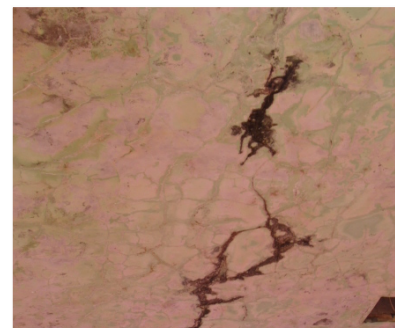
I11. Grietas en los elementos estructurales debido a las filtraciones de agua.
