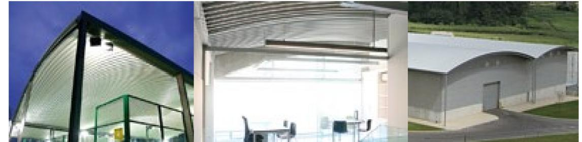
Para la cubierta se utilizará un sistema autoportante que se apoya únicamente en sus extremos, es decir en las vigas metálicas que serán perfiles en I, ya que este elemento permite el fácil mantenimiento.
