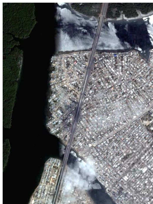
Fig. 22. Vista satelital de la vía Perimetral cruzando el sector de la Isla Trinitaria hacia el suburbio oeste, uno de los lugares de concentración de pobreza y vulnerabilidad urbana. Esta zona está rodeada por los ramales del Estero Salado y Santa Ana, que al incrementarse el nivel máximo de marea en 20 años, provocará un fuerte impacto socio-económico, siendo quizás estos los primeros migrantes climáticos de la ciudad. Fuente: Google Earth
