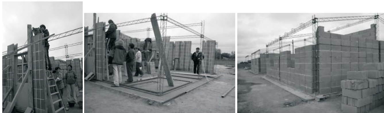
Imagen 56. Construcción viviendas MIDUVI
