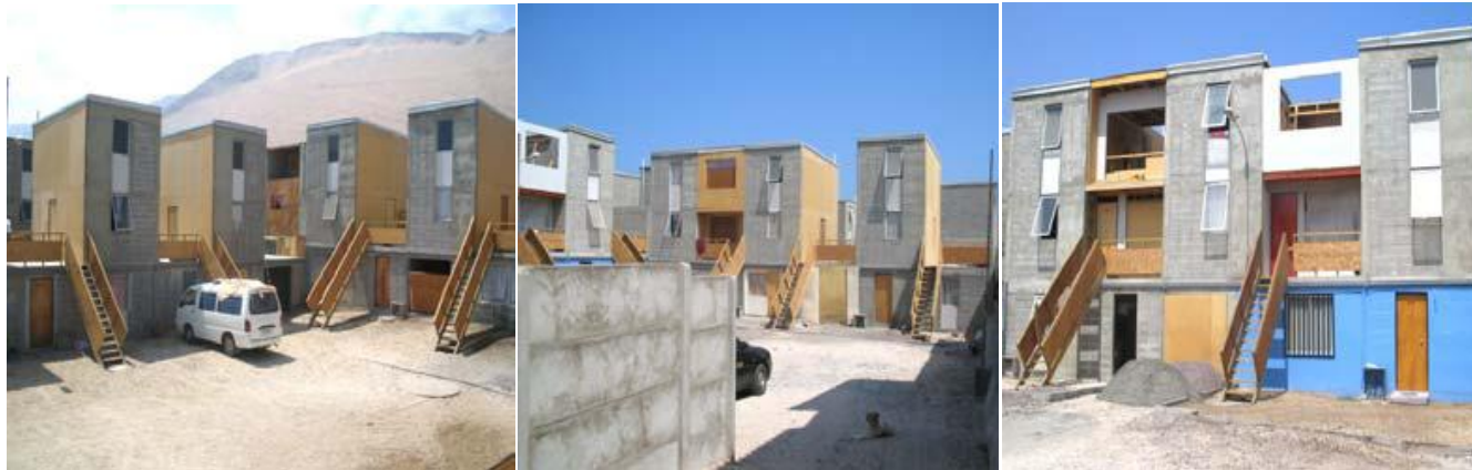
Imagen 2. Izquierda, centro, espacio colectivo, derecha intervención autoconstrucción en fachada.
