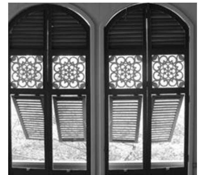
Imagen 46. Chazas de madera Fuente: Arquitectura Tradicional en Guayaquil.
