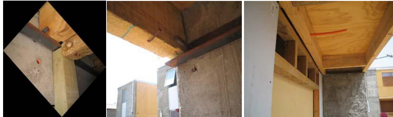
Imagen 17. Engigados entrepiso hombro y perfil metálico, insertos de estriado en muro de hormigón armado. Fuente: Registro alumnos Arquitectura UCN, abril [2005]. La acción de usuario en materia de intervención en su vivienda ha sido guiada por una asistencia técnica de ELEMENTAL, lográndose una cierta calidad y seguridad en las soluciones constructivas empleadas.
