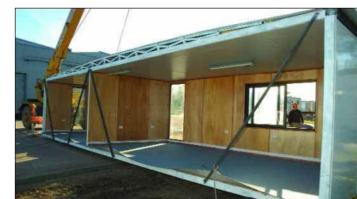
Imagen 31. paneles de yeso o cemento (vista pared doble)
