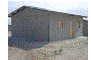
Estructura Metálica y Concreto
