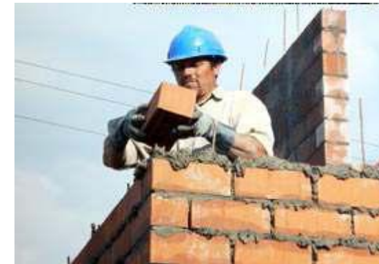
Imagen 27. Cerramientos verticales, muros de ladrillos
