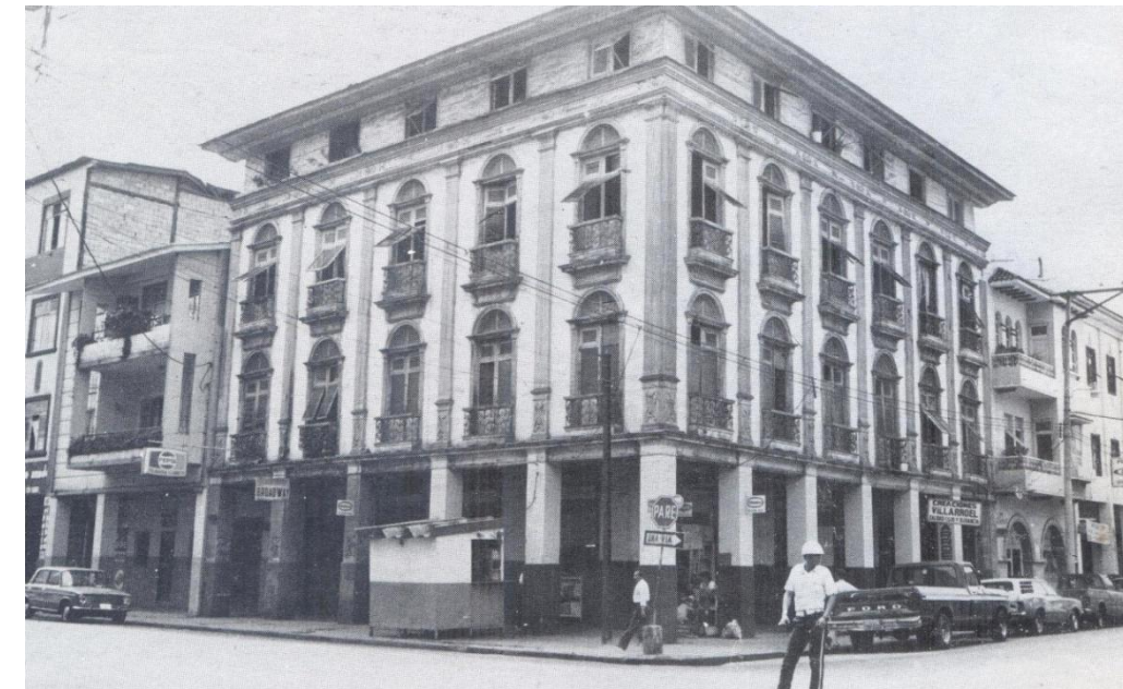
Imagen 43. Ejemplo de Casona Multifamiliar construida en madera. Fuente: Patrimonio Arquitectónico y Urbano de Guayaquil
