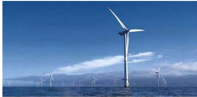
Instalación de aerogeneradores offshore (mar adentro).
