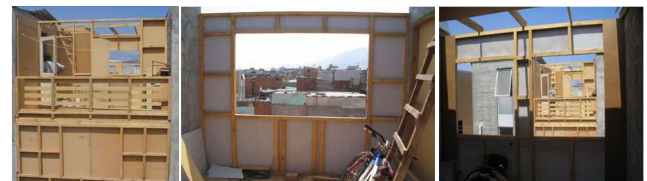
Imagen 16. Uso de tabiquerías livianas entre medianeras. Fuente: Registro alumnos Arquitectura UCN, abril [2005]. La estructura de muros ordenan y contienen el desarrollo de la intervención del usuario por autoconstrucción, evitando su desarrollo descontrolado.
