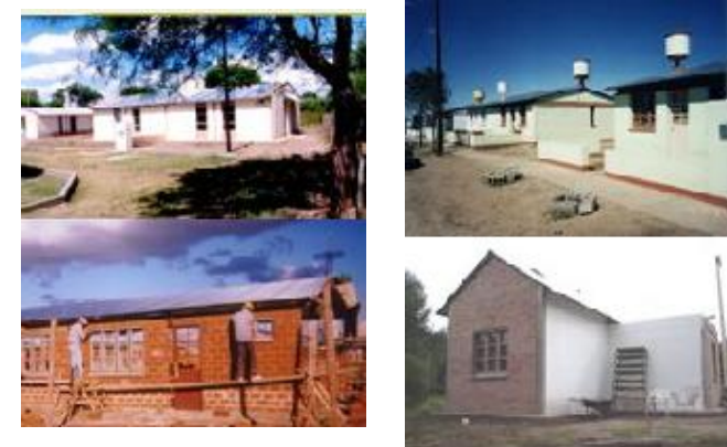
Imagen 39. Se construyeron 18 viviendas de 50 m 2 como respuesta habitacional a la emergencia de un derrumbe en 1992
