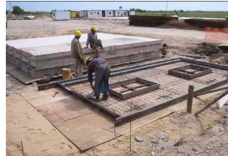
Imagen 35. Hormigón prefabricado con uniones húmedas
