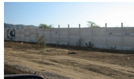
-Fachada que da a la Av. Machalilla.
