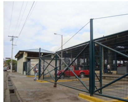
Al fondo, cuarto de maquinas entre deposito de desechos (atrás) y área de descarga de camiones
