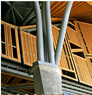
Las columnas la conforman un conjunto de elementos verticales que a manera de "racimo"
