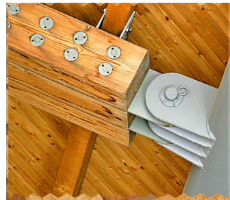
Ensamblajes en madera con piezas metálicas
