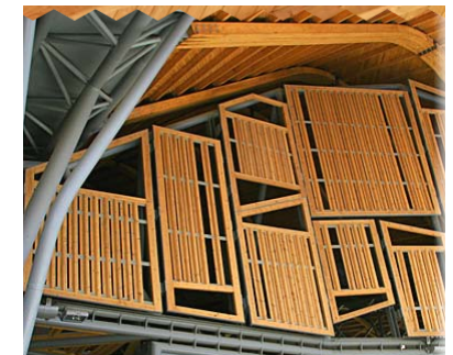
Paneles de madera en fachada posterior
