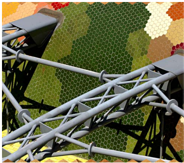
Viga metálica superior tensada
