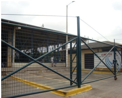
Andenes para descarga de mercadería.
