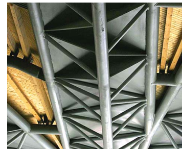
Cerchas metálicas en cubierta
