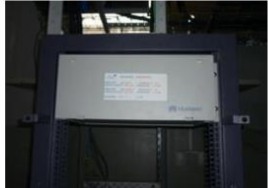
Figura 4.39: Etiqueta de identificación en un ODF
