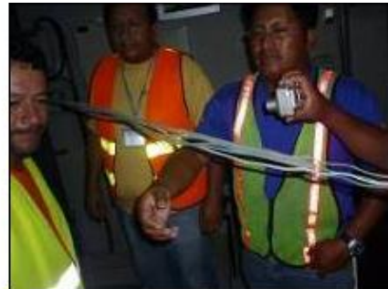
Figura 4.11: Buffers con tubo de transporte
