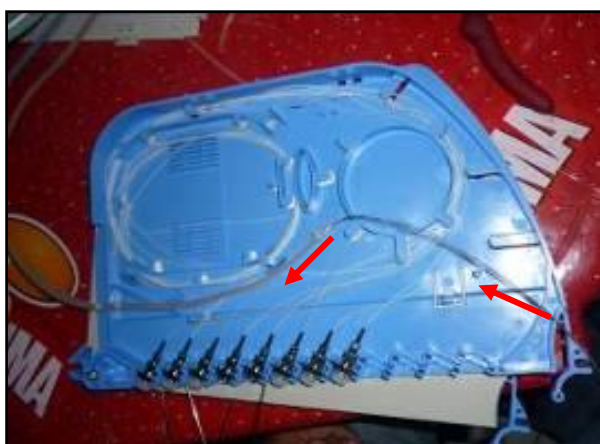
Figura 4.31: Colocación de Buffer en bandeja
