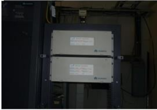
Figura 4.38: Etiquetas de identificación en dos ODF
