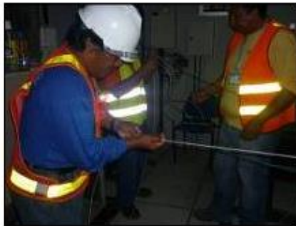
Figura 4.10: Colocación del tubo de transporte
