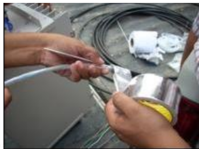
Figura 4.13: Colocación de cinta en cable (a)
