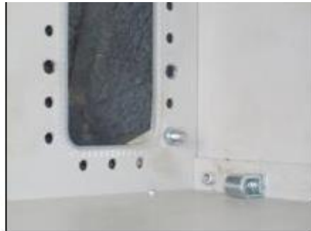
Figura 4.26: Instalación de terminal
