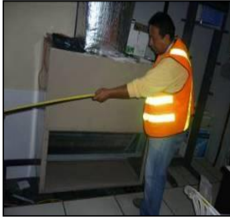
Figura 4.4: Medición del cable para corte de chaqueta
