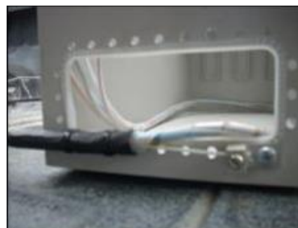
Figura 4.22: Colocación de amarras (b)
