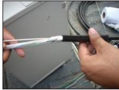
Figura 4.16: Colocación de termofundente en cable
