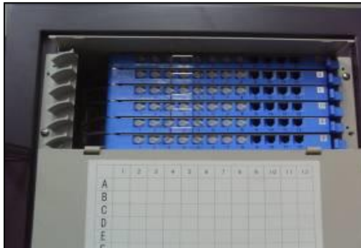
Figura 4.37: ODF con las bandejas porta-empalmes organizado
