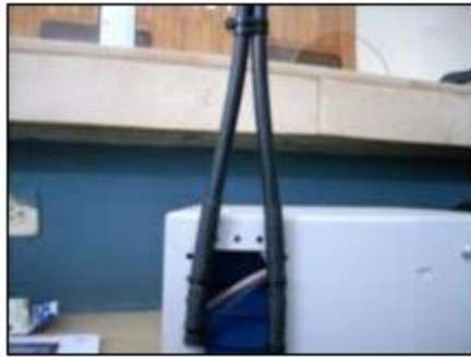
Figura 4.23: Ingreso de 2 cables a ODF (a)
