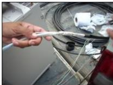
Figura 4. 14: Colocación de cinta en cable (b)
