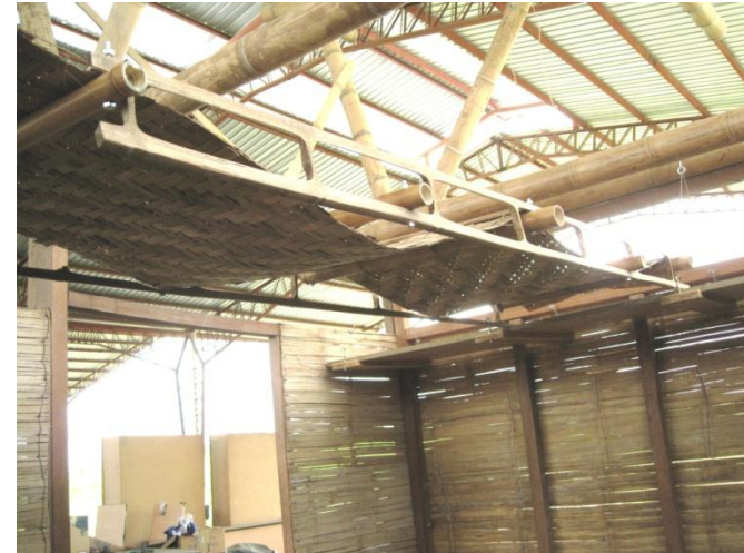
Laminas de G.A.K. 1.00x0.50m . Estructura de G.A.K. y phyllotachys aurea.
