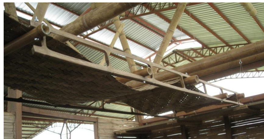
Laminas de G.A.K. 1.00x0.50m . Estructura de G.A.K. y phyllotachys aurea.
