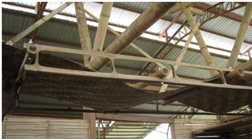
Laminas de G.A.K. 1.00x0.50m . Estructura de G.A.K. y phyllotachys aurea.
