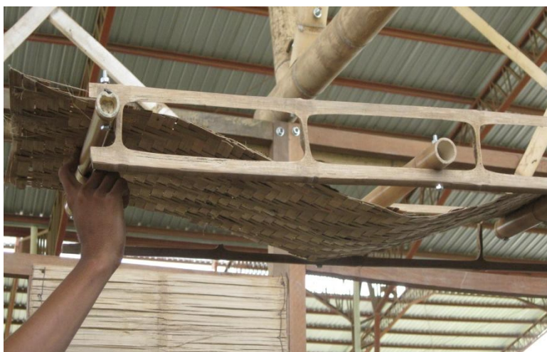
Laminas de G.A.K. 1.00x0.50m . Estructura de G.A.K. y phyllotachys aurea.
