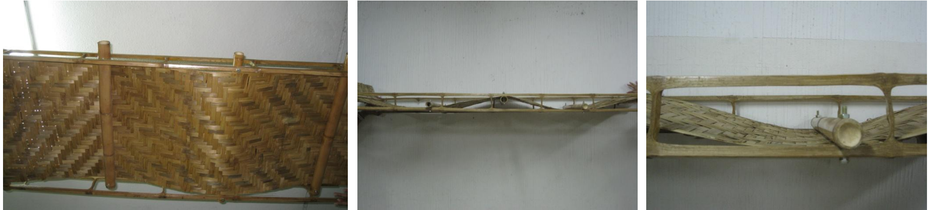
Cielo Raso de Esteras con acabado.
