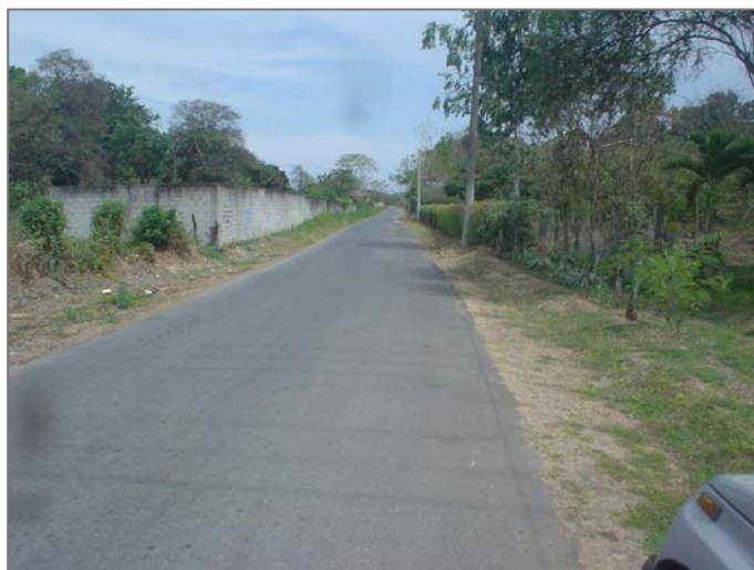
6) Vía asfaltada de acceso secundario
