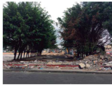
Figura 2. Escombros de la construcción anterior
