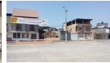
Foto 2. Vista hacia Calle Vehicular.
