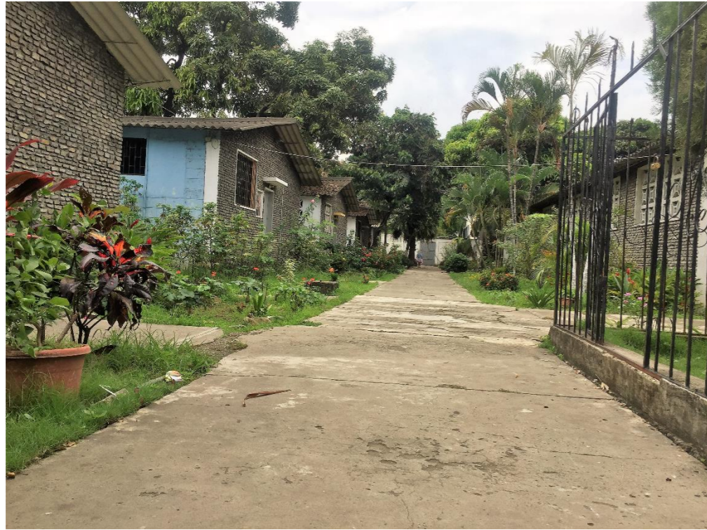
Inexistencia de rampas de acceso
