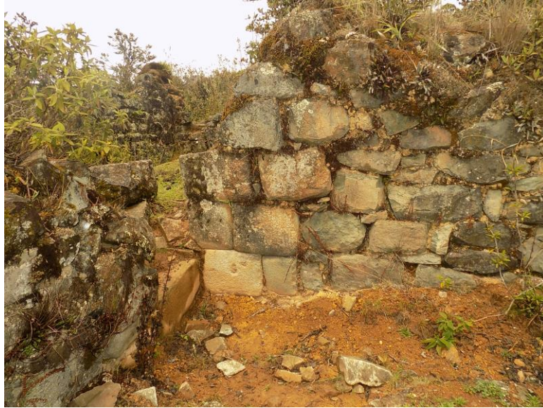
Figura N°27: Estructuras de Piedra.
