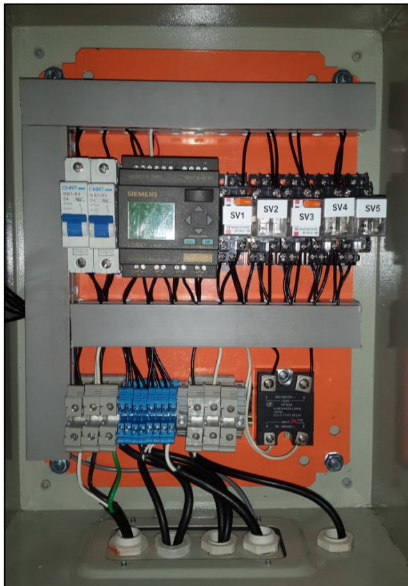
Figura 7. 4: Sistema de control modificado Elaborado por: Autor
