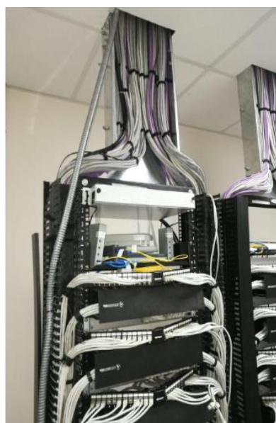
Figura 3.14: Fibras sangradas que estarán situadas en el ODF Elaborado por: Autor
