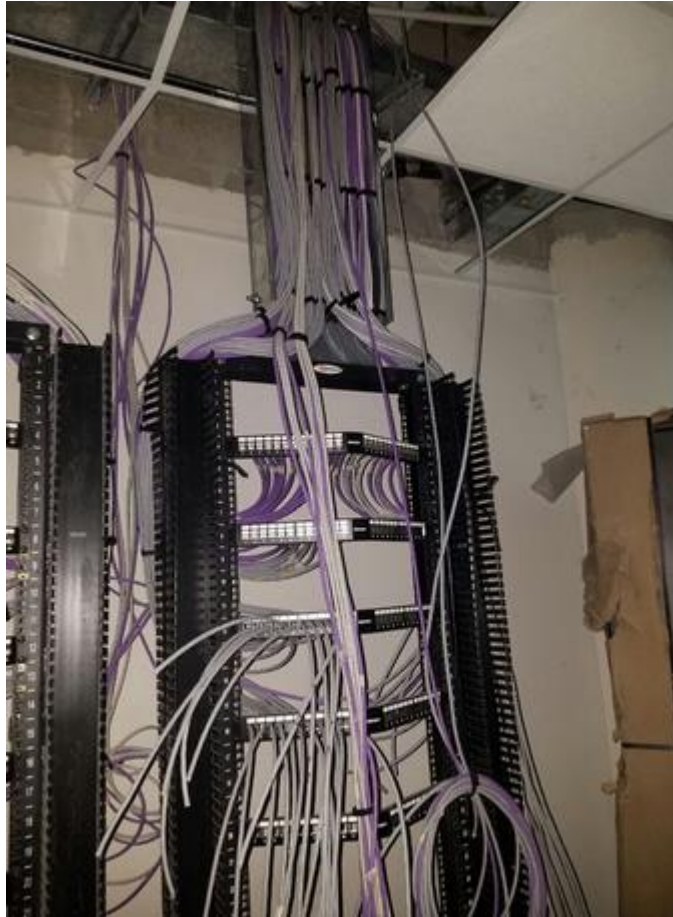
Figura 3.15: Ductos hacia las oficinas administrativas Elaborado por: Autor
