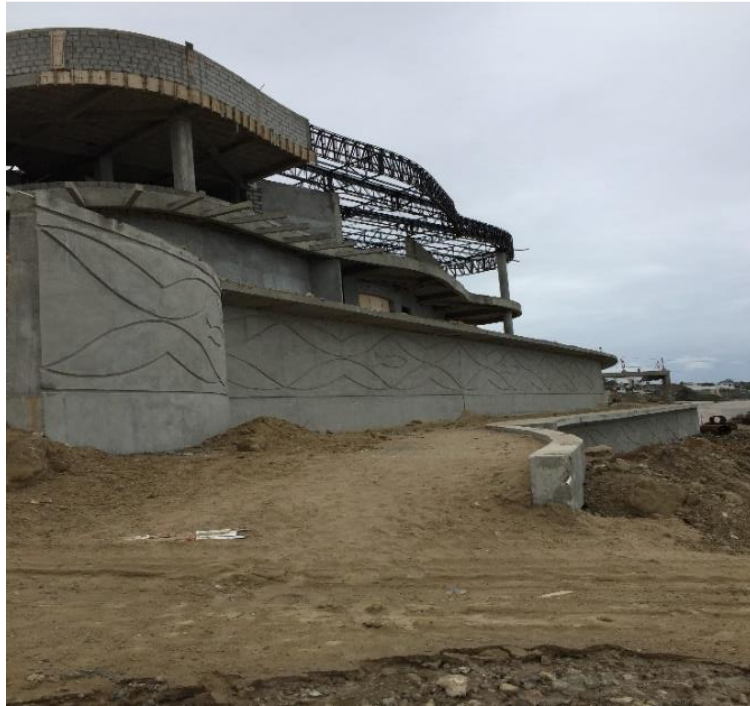
Obra en construcción del malecón de Ballenita
