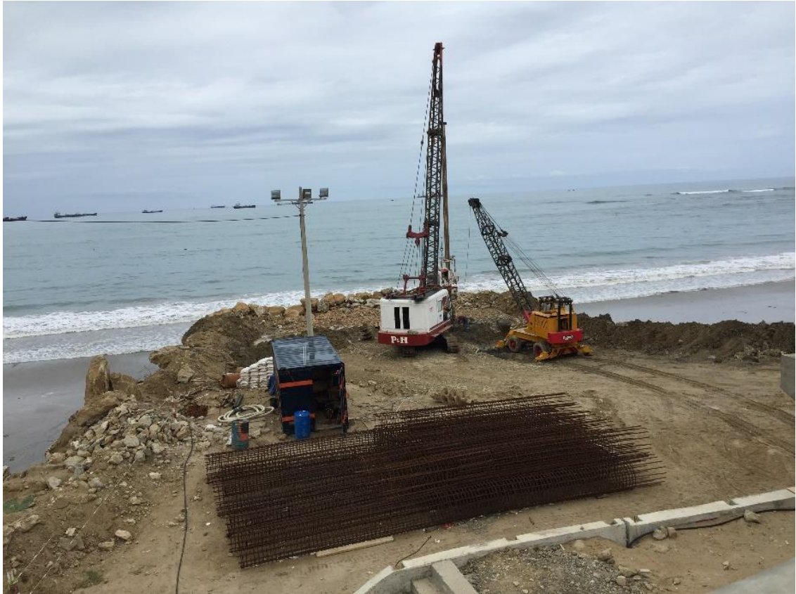
Construcción de área de glorieta para el malecón
