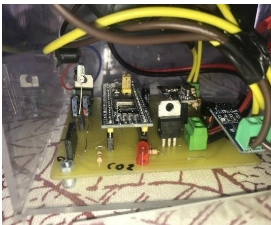
Figura 42. Tarjeta electrónica final del bloque de control de cargas. Fuente: Elaboración propia.
